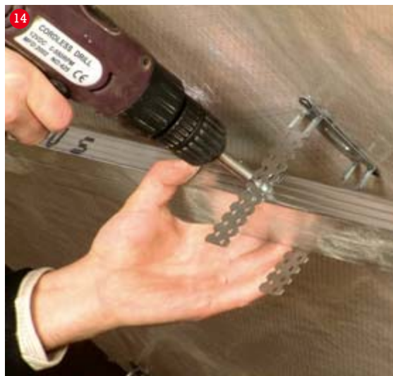
Zavěšení pohledu s tep. izolací pod parozábranou pomocí přímého závěsu
