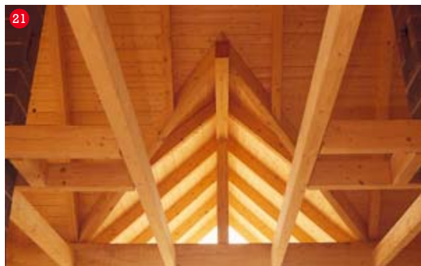
Atmosféra dřevěné konstrukce při zateplení nad krokvemi
