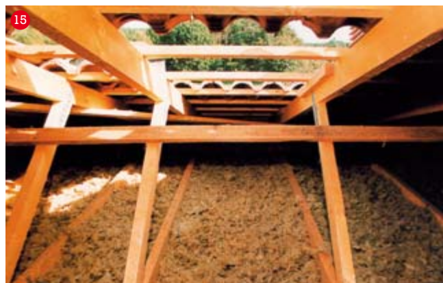
Vazníková střecha – izolace stropu
