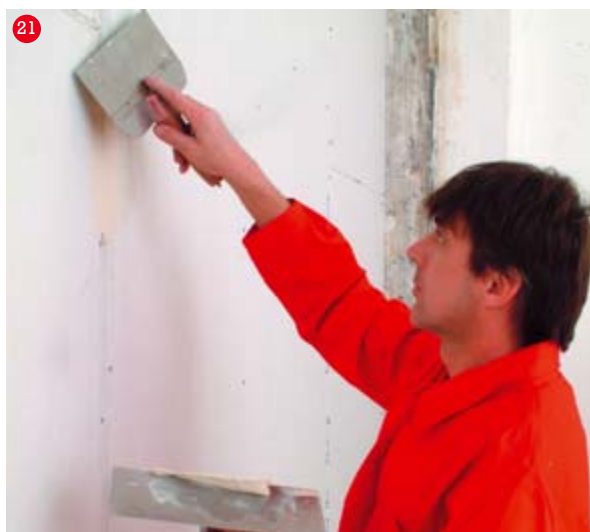
Vyplnění spár mezi deskami tmelem
