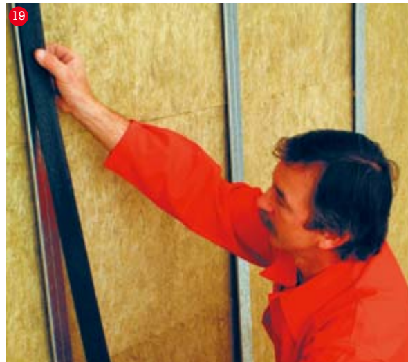
Lepení separační samolepicí PE pásky na kovové profily
