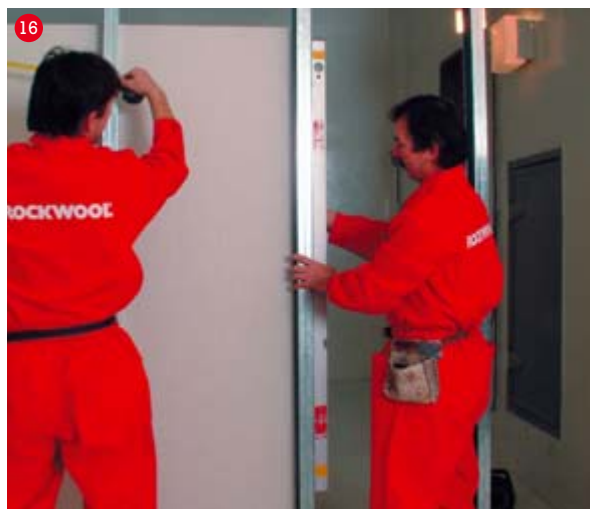
Montáž kovových nosných profilů
