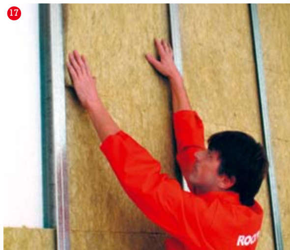
Vyplnění příčky akuzolací
