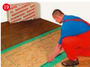
Pokládka druhé roznášecí vrstvy
