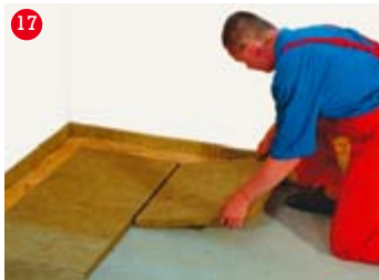
Pokládka izolace Steprock HD
