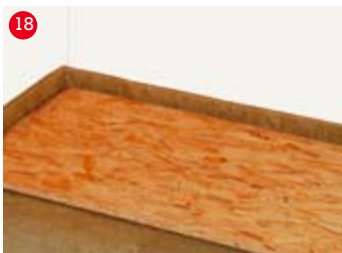
Okrajový pásek Steprock a první roznášecí vrstva
