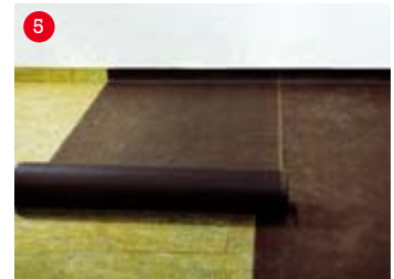
Pokládka hydroizolační vrstvy
