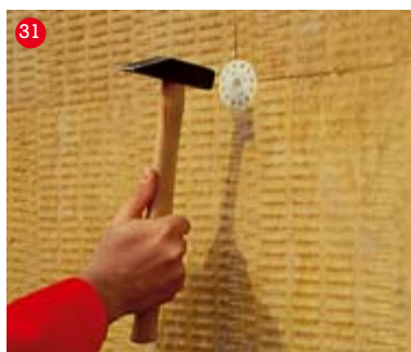
11. Upevnění talířové hmoždinky
