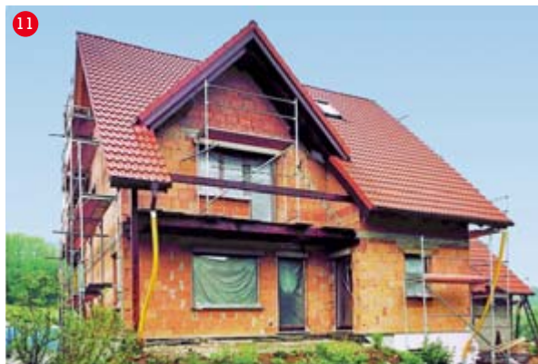
11 Stav domu před zateplením
