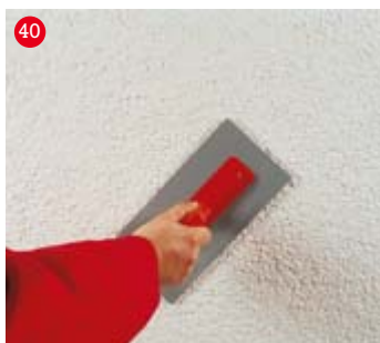
20. Hlazení krouživým pohybem
