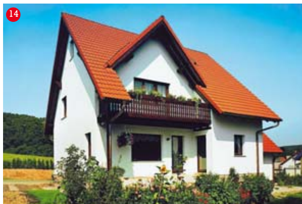
14 Konečný stav domu po zateplení
