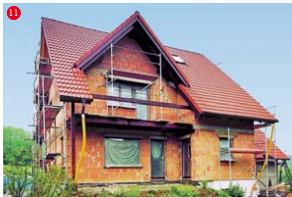
11 Stav domu před zateplením
