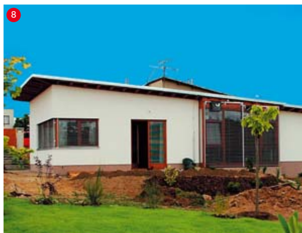
Fasáda zateplená kontaktním systémem
