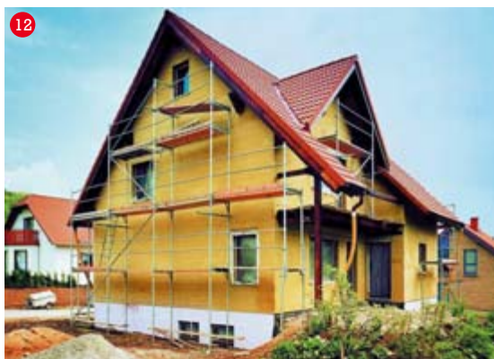
12 Zateplení fasády materiálem Rockwool
