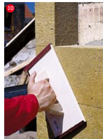
Kontaktní zateplovací systém
