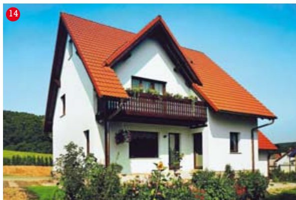
14 Konečný stav domu po zateplení
