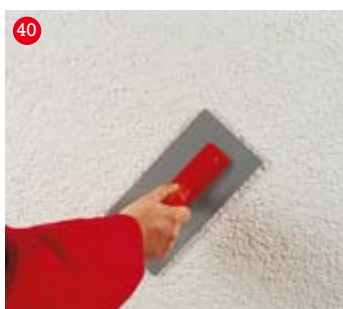
20. Hlazení krouživým pohybem
