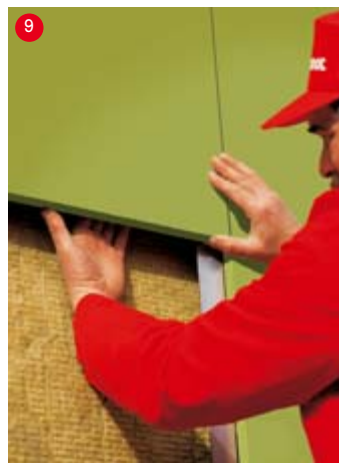
Provětrávaný zateplovací systém
