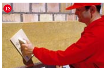
13 Provádění izolace Rockwool
