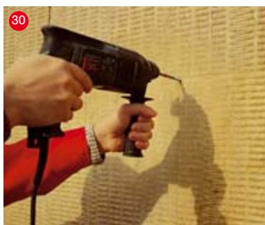
10. Vrtání otvoru
