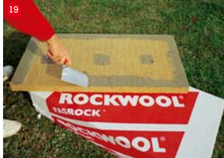
4. Nanesení základní vrstvy lepidla
