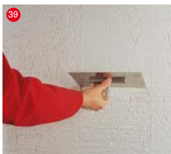
19. Stažení nadbytečné omítky
