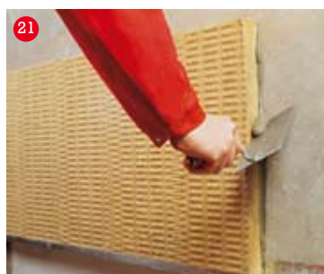
6. Odstranění přebytečné lepicí hmoty
